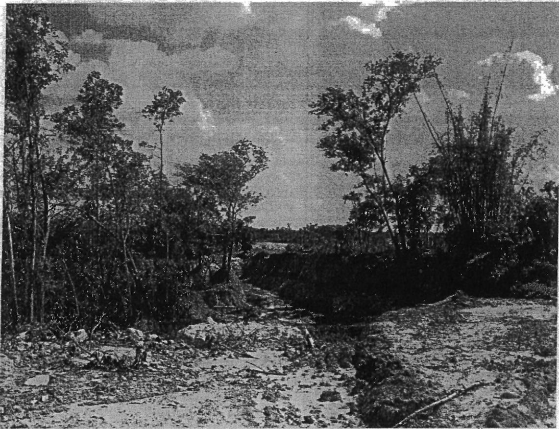
ภาพที่ 5 ขอบบ่อด้านทิศตะวันตก มีการถมปรับความลาดชันป้องกันการพังทลายเนื่องจากน้ำหลาก
